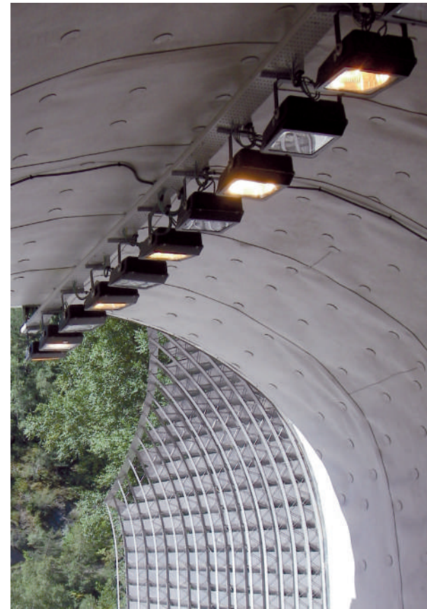
Infraestructura viaria: túnel
