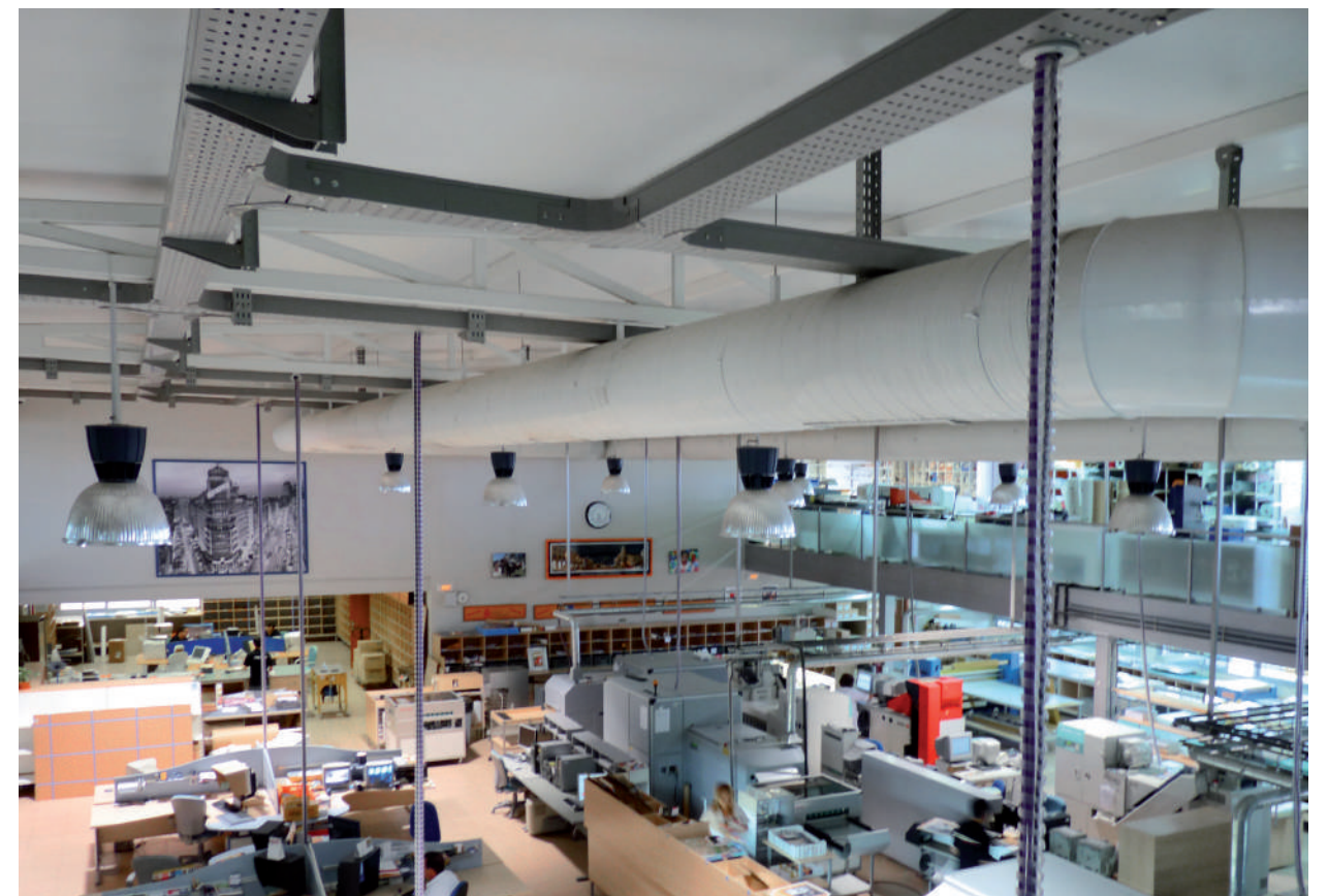
Nave industrial: oficina
