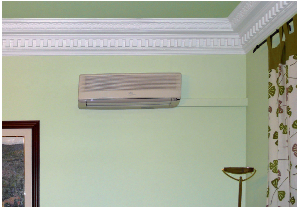
Rehabilitación de viviendas
