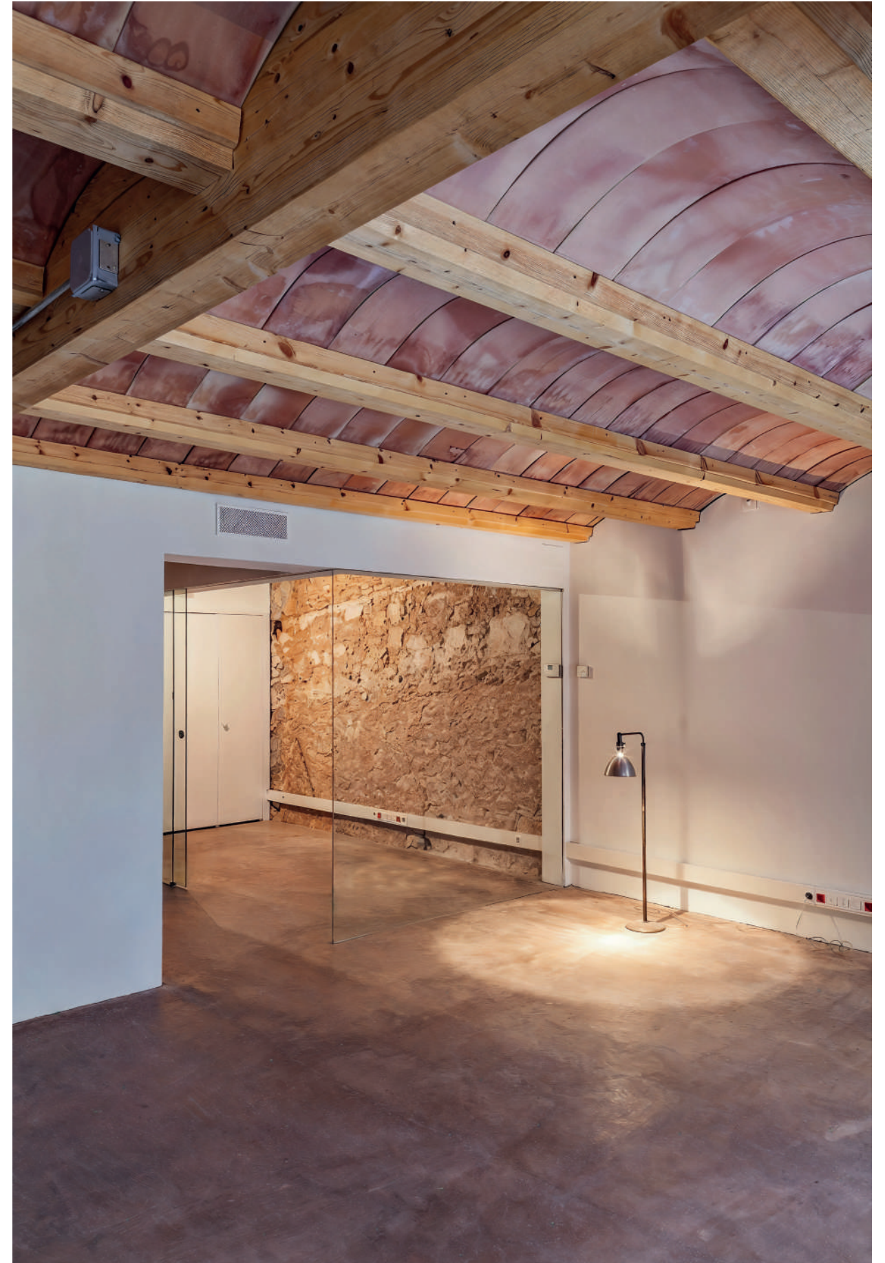
Espacios de trabajo: rehabilitación de oficina
