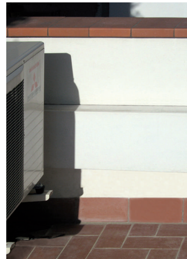
Rehabilitación de viviendas
