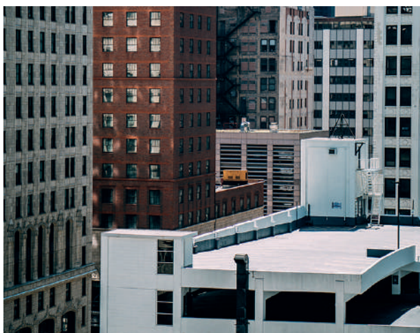
Instalaciones en azoteas
